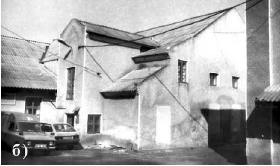
Іл. 5б. Вид з південного сходу на будівлю колишньої божниці, 1990-ті рр.
