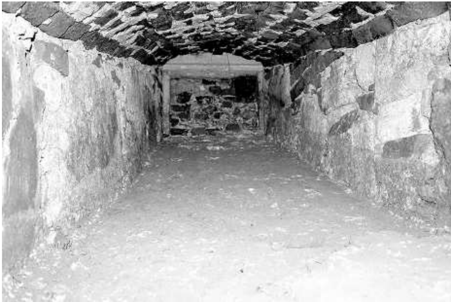
Рис. 1. Внутрішня частина прорізу вікна 1. Вигляд із півночі
